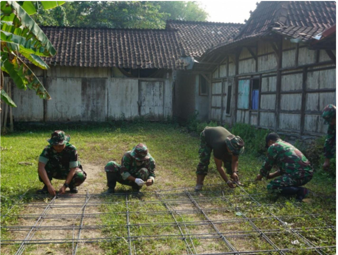
*Gunakan Besi Wiremesh Untuk Membangun Jalan Rabat Beton Program TMMD Reguler Ke 114 Kodim 0716/Demak*
